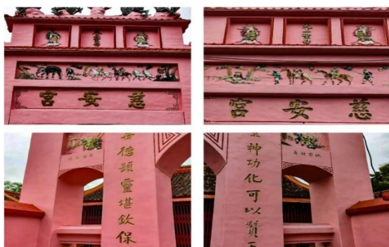
Gambar 3. Pintu utama Kelenteng Cu An Kiong Lasem
